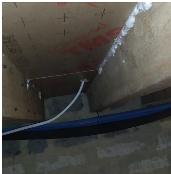
Figure 56 : Photo d'une isolation sous plancher bois en polyuréthane.
