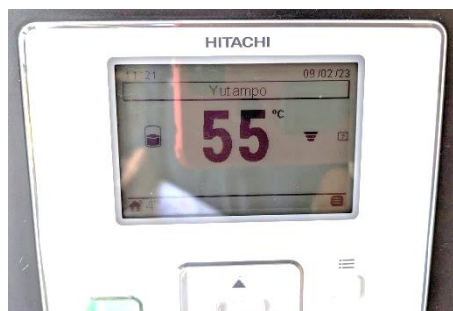
Figure 104 : Afficheur du ballon thermodynamique du logement 400201, lors de l'instrumentation.
