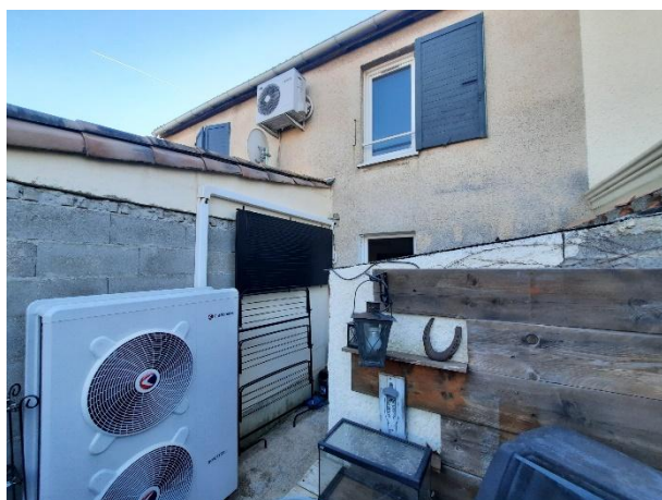
Figure 69 : Capteur aéro-solaire mal positionné.
