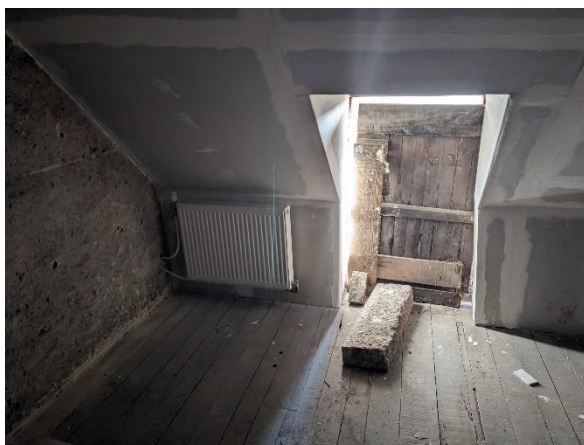
Figure 68 : Cas isolé d'un radiateur qui chauffe en volume non chauffé (pas de menuiserie).
