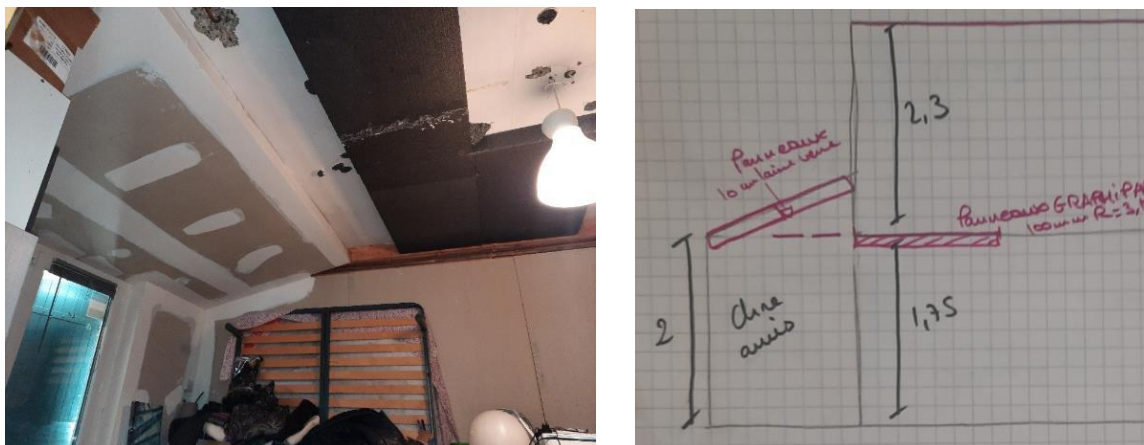
Figure 57 : Photo d'une isolation en sous-face de dalle... qui s'avère inutile !
