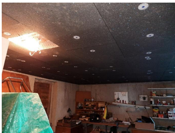
Figure 55 : Photo d'une isolation sous dalle avec un défaut d'isolation au niveau du luminaire.
