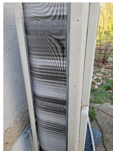
Figure 70 : Unité extérieure de ballon thermodynamique givrée.
